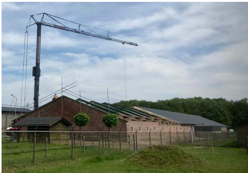
Renovatie aanstaand zonnedak Cees Schoenmakers Haaren
